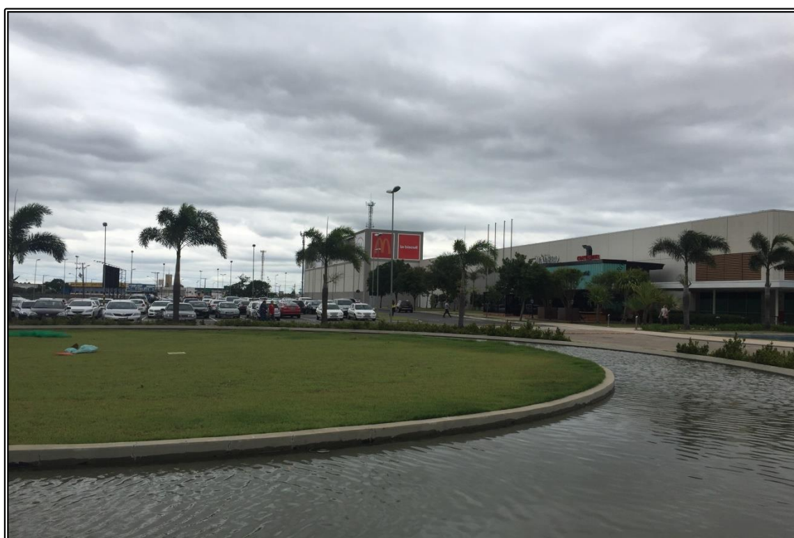
FACHADA LATERAL E ESTACIONAMENTO
