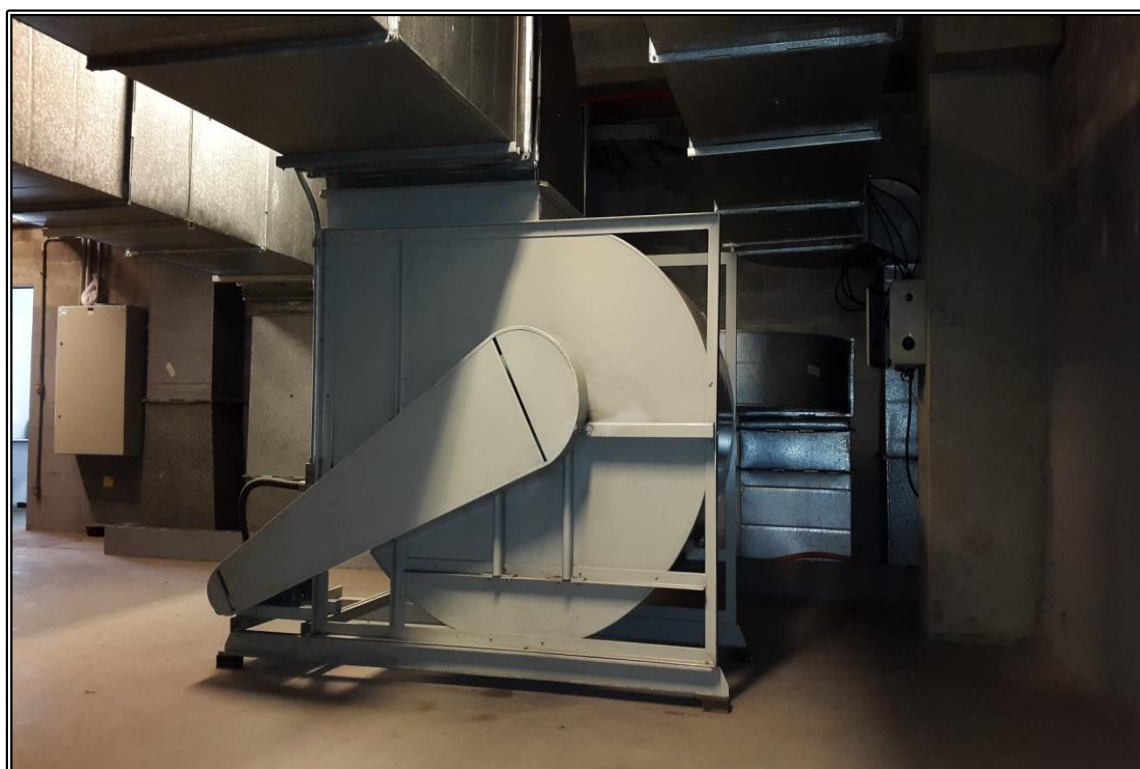
EXAUSTOR DE FUMAÇA
